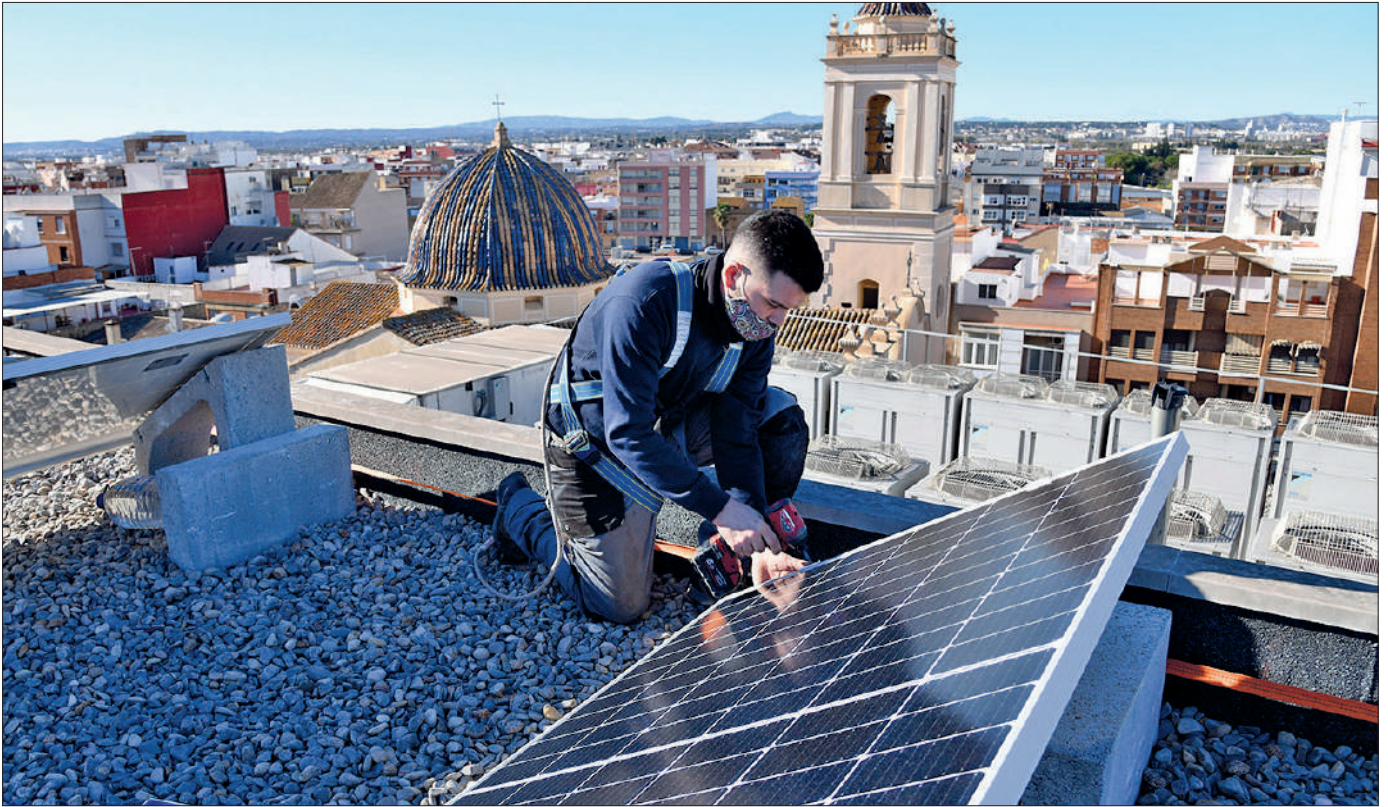
Un tècnic instal·la un panell solar a un edifici de Paiporta. FOTO ARXIU
